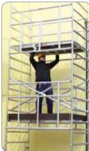
7. Se coloca la plataforma por debajo de la barandilla instalada
