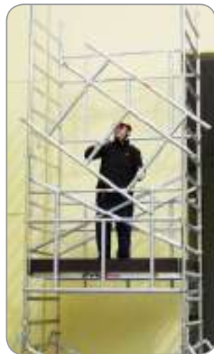
2. Las barandillas del siguiente nivel, se colocan desde la plataforma
