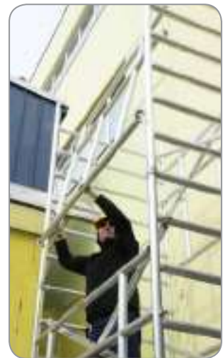
4. Barandillas equipadas con ganchos rápidos
