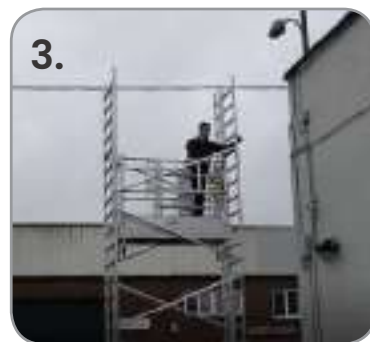
3. Ensamblar el marco lateral
