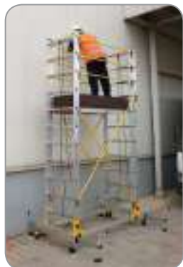
TT006 cerrado. Altura de plataforma: 2,34 m
