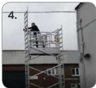
4. Colocar las abrazaderas
