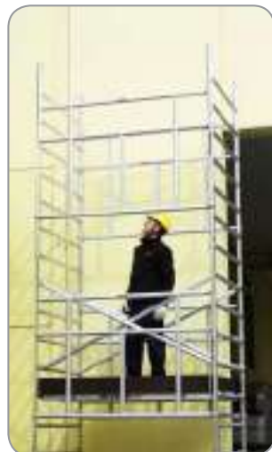
6. El operario queda perfectamente asegurado durante el proceso
