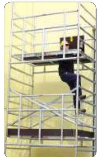
8. El operario puede acceder al nivel superior a través de la trampilla
