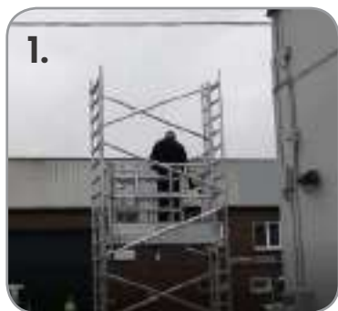
1. Montar los marcos necesarios a bordo de la plataforma
