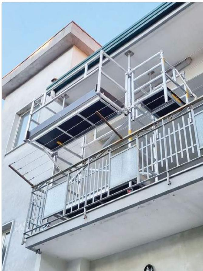
Estructura tubular de aluminio de muy alta resistencia mecánica. Fabricado especialmente para el mantenimiento de balcones.
