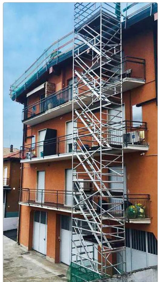
Este andamio adopta el sistema de montaje **SERVOTECH** auxiliar para el montaje de barandillas.
