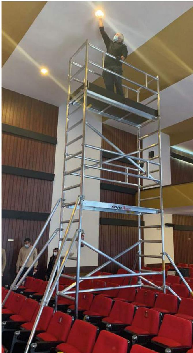
Andamio de aluminio conforme a normativa europea UNIEN1004.1.2, ideal para uso en presencia de escalones, terreno inclinado, filas de sillas o sillones.
